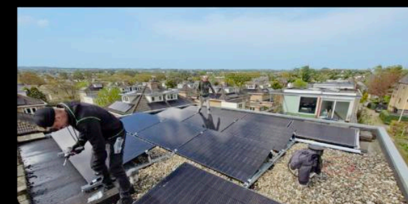
Falownik hybrydowy, akumulator wysokonapięciowy Rotterdam, Holandia, moc 10kW
