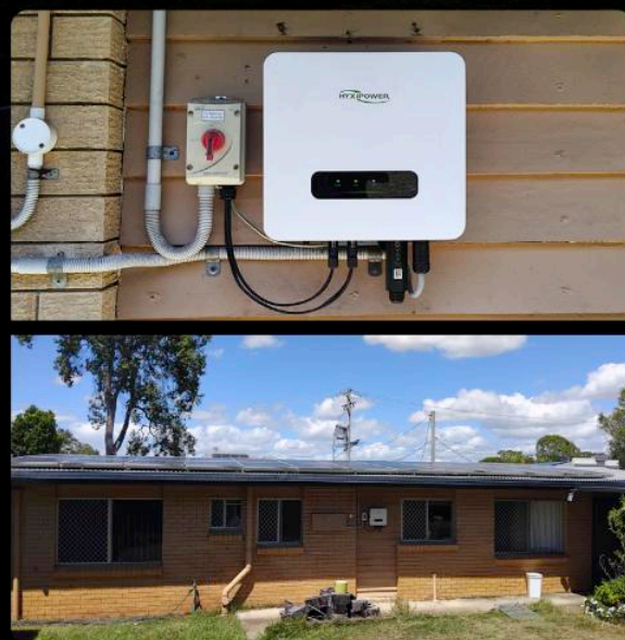
Falownik hybrydowy Brisbane, Australia, moc 6,6kW
