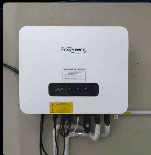
Falownik hybrydowy Queensland, Australia, moc 6,6kW
