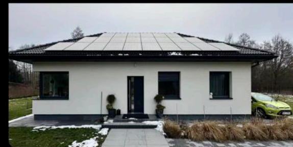
System magazynowania energii All-in-One Mazowsze, Polska, moc 10kW
