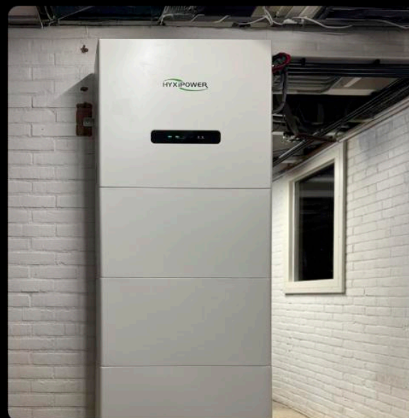
System magazynowania energii All-in-One Overijssel, Holandia, moc 12kW / pojemność 20kWh
