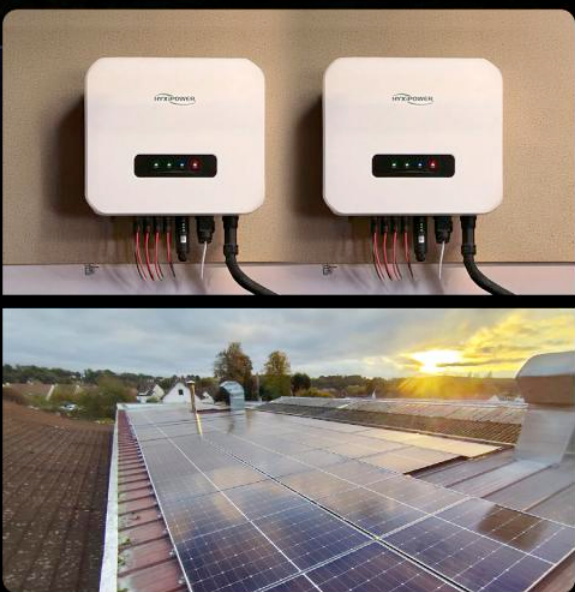
String-Wechselrichter Eure-et-Loir, Frankreich, Anlagenleistung 45 kW
