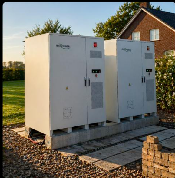
C&I-Energiespeicher 105 kW / 232 kWh Niederlande, Anlagenleistung 200 kW / 430 kWh
