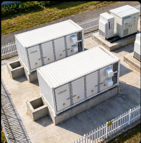
5000-kWh-Container-Energiespeicher Zhejiang, China, Anlagenleistung 5 MW / 10 MWh
