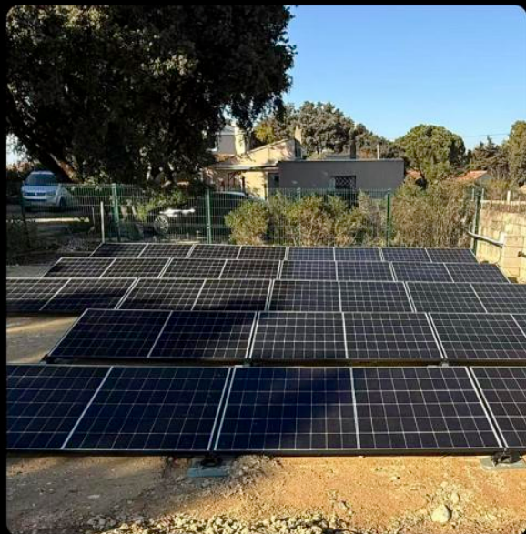
Mikrowechselrichter Orange, Frankreich, Anlagenleistung 9 kW
