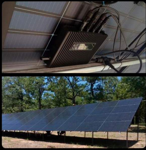
Microinversor Arkansas, EE. UU., capacidad: 11,6 kW
