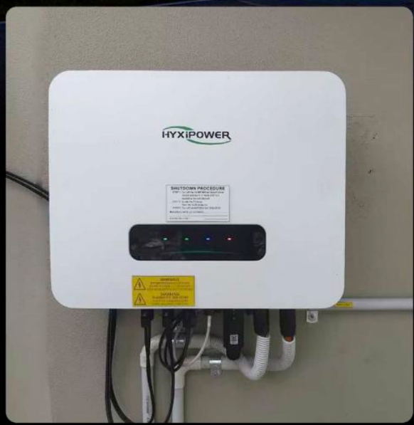
Inversor híbrido Queensland, Australia, capacidad: 6,6 kW
