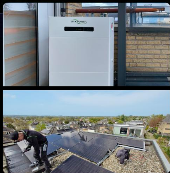
Inversor híbrido, batería de alta tensión Róterdam, Países Bajos, capacidad: 10 kW
