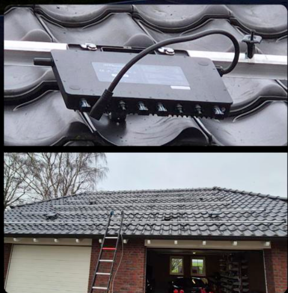
Microinversor Drenthe, Países Bajos, capacidad: 7,9 kW
