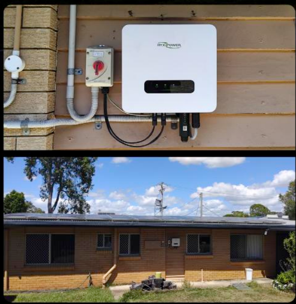
Inversor híbrido Brisbane, Australia, capacidad: 6,6 kW
