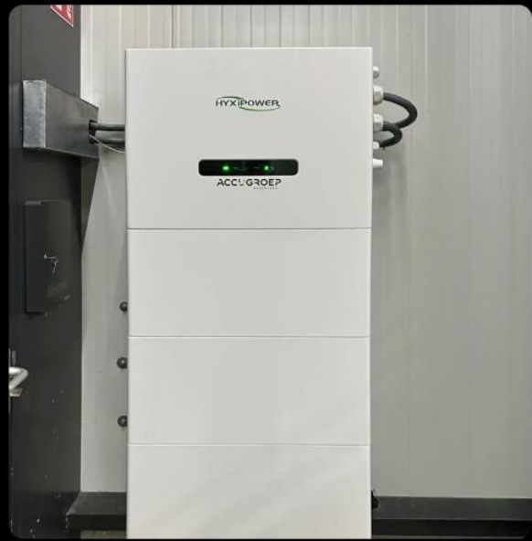
Sistema de almacenamiento de energía (ESS) «todo en uno» Overijssel, Países Bajos, capacidad: 12 kW/20 kWh
