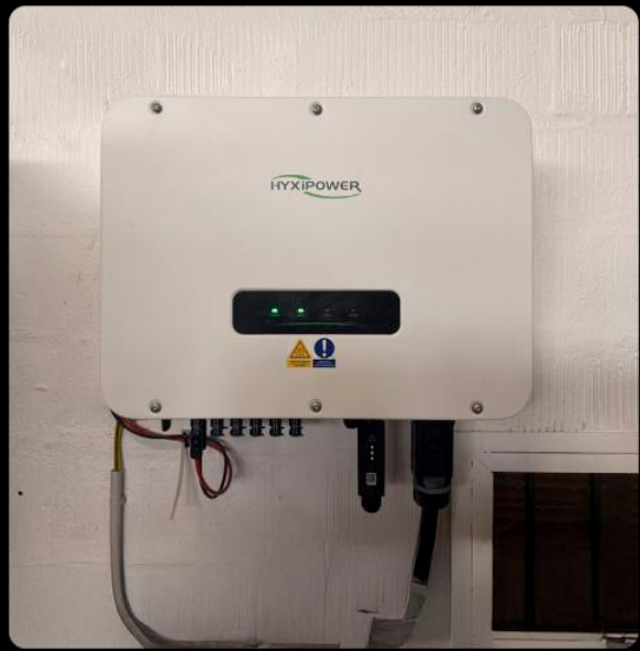
Microinversor Drenthe, Países Bajos, capacidad: 7,9 kW
