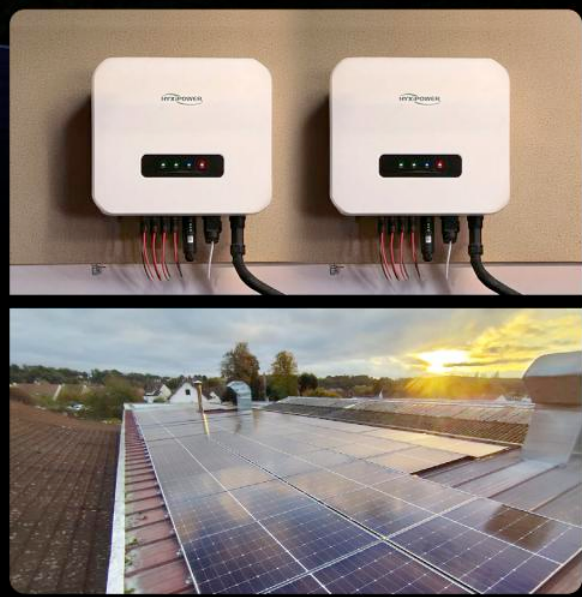
Inversor String Eure-et-Loir, Francia, capacidad: 45 kW
