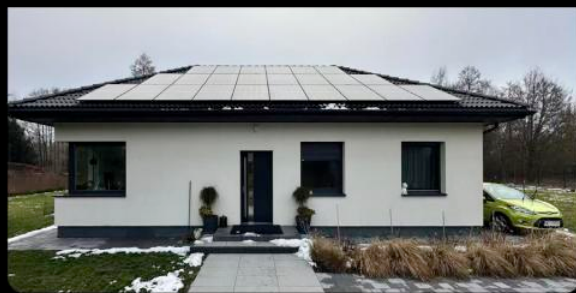
Sistema de Armazenamento de Energia Integrado Mazovia, Poland, Capacidade 10kW
