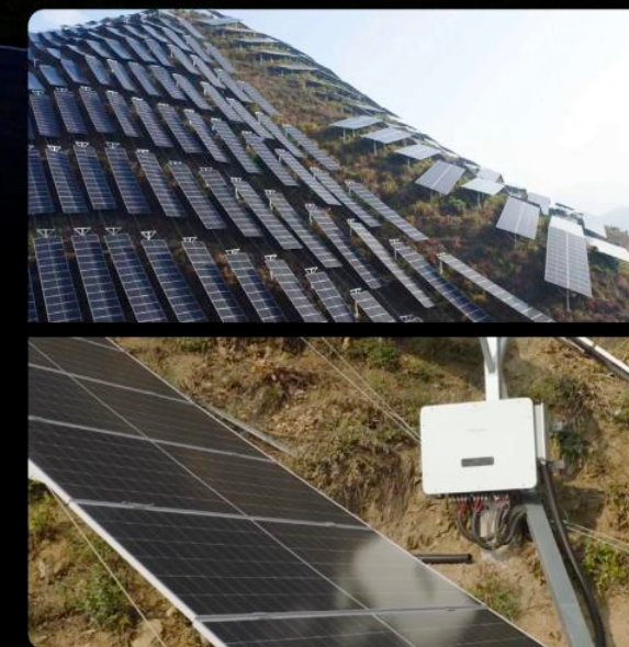
Inversor de String Hangzhou, China, Capacidade 40MWp
