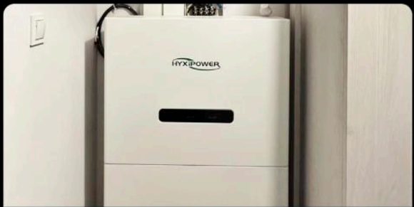
Hybrid-Wechselrichter, Hochvolt-Batterie Madrid, Spanien, Anlagenleistung 5,28 kW
