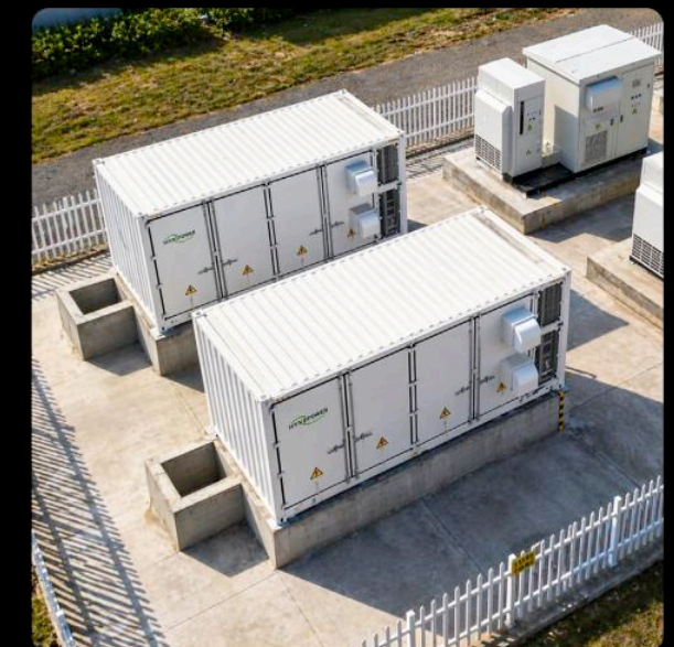
5000-kWh-Container-Energiespeicher Zhejiang, China, Anlagenleistung 5 MW / 10 MWh
