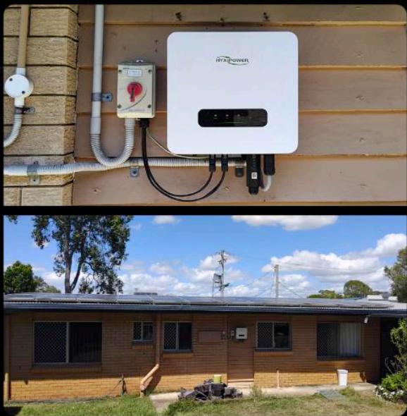
Hybrid-Wechselrichter Brisbane, Australien, Anlagenleistung 6,6 kW
