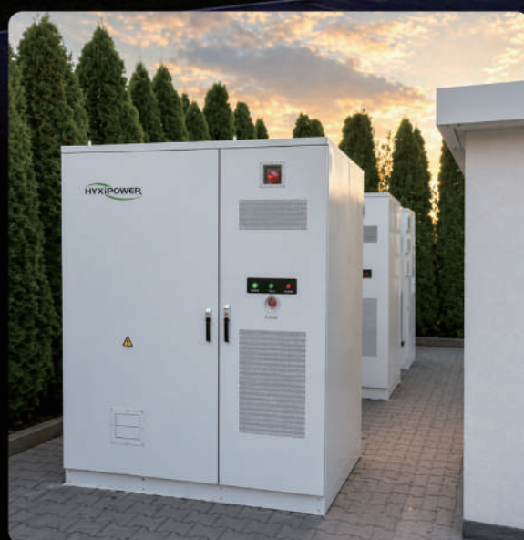
100kW/215kWh C&I ESS Poland, Công suất 200kW/430kWh
