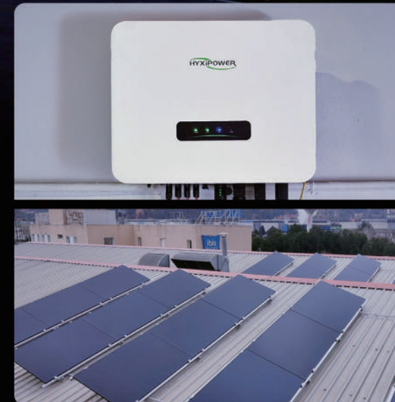
Biến tần lai Barcelona, Spain, Công suất 25kW
