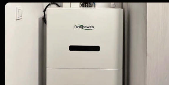
Biến tần lai, Pin cao áp Madrid, Spain, Công suất 5.28kW
