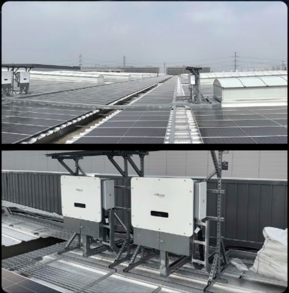
320kW 组串逆变器 中国浙江 规模 36MWp
