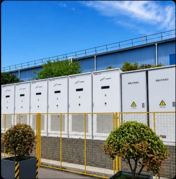
105kW/232kWh 一体柜 中国上海 规模 3.25MW/6.79MWh
