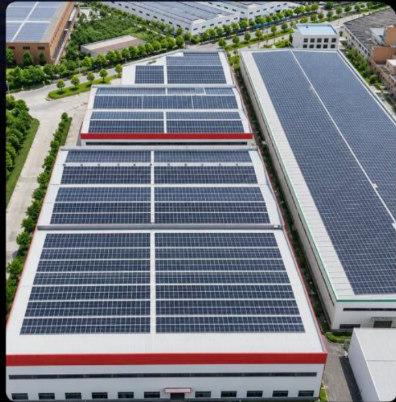
120kW、320kW 组串逆变器 中国浙江 规模 30MWp
