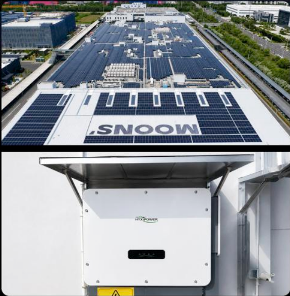
320kW 组串逆变器 中国江苏 规模 4.67MWp
