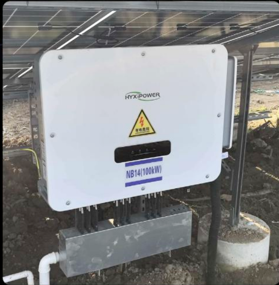
320kW 组串逆变器 中国河北 规模 5.31MWp
