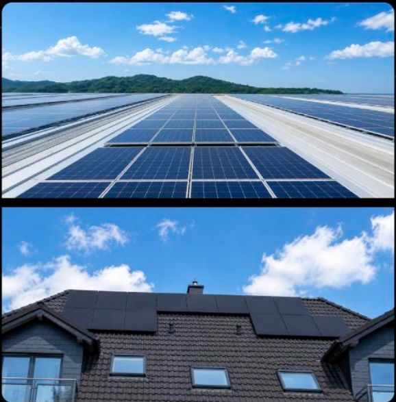
320kW 组串逆变器 中国重庆 规模 6MWp
