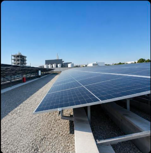
320kW 组串逆变器 中国山东 规模 6MWp
