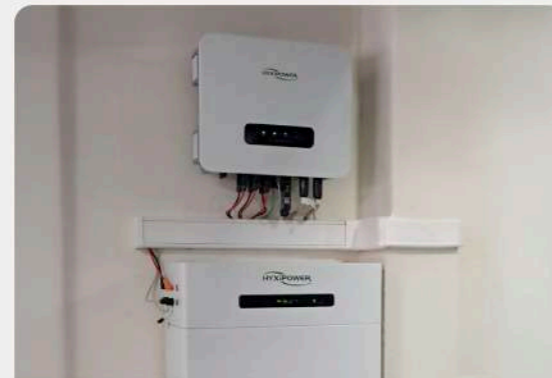
Hybride Omvormer Queensland, Australië Capaciteit 6,6kW
