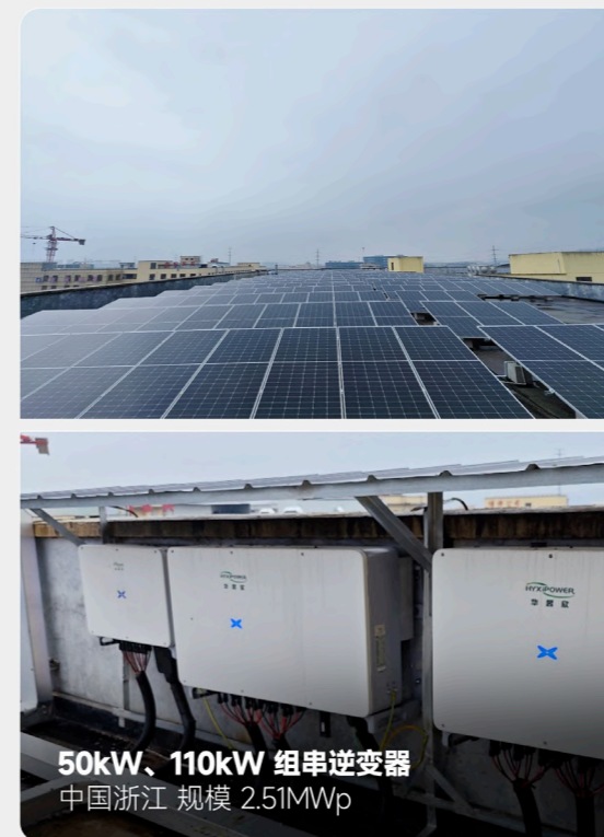
50kW、110kW组串逆变器 中国浙江 规模 3.67MWp
