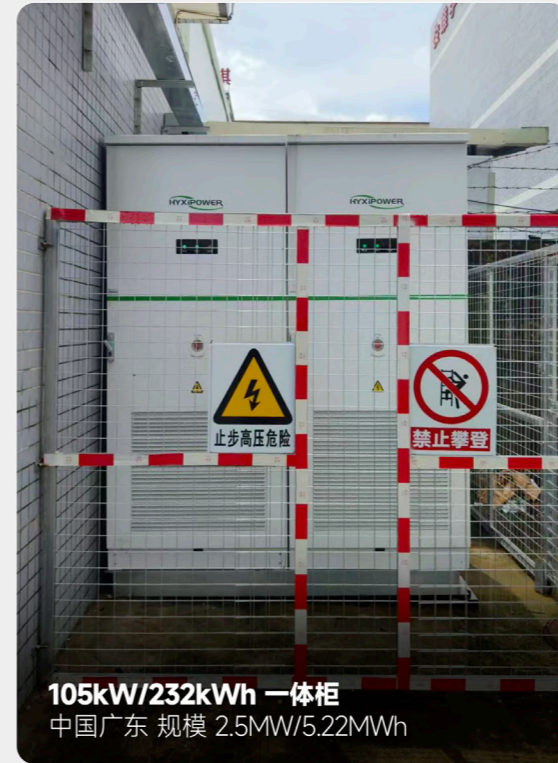
105kW/232kWh 一体柜 中国广东 规模 2.32MW/4.64MWh
