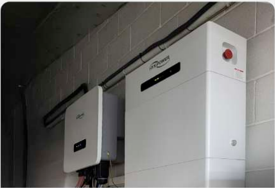
Onduleur réseau Eure-et-Loir, France Capacité 45kW
