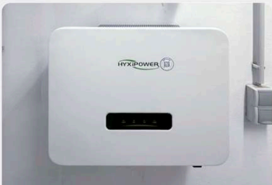
Inverter a Stringa Eure-et-Loir, Francia Capacità 45kW
