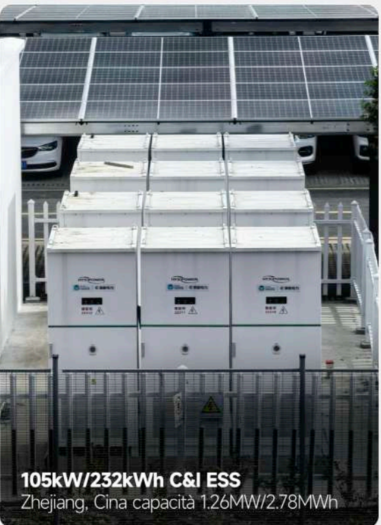
105kW/232kWh C&I ESS Zhejiang, Cina capacità 1.26MW/2.78MWh
