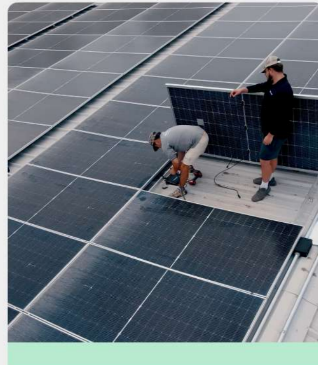
4-en-1 & 2-en-1 Micro-onduleur Nacogdoches, Texas, USA Capacité 117kW
