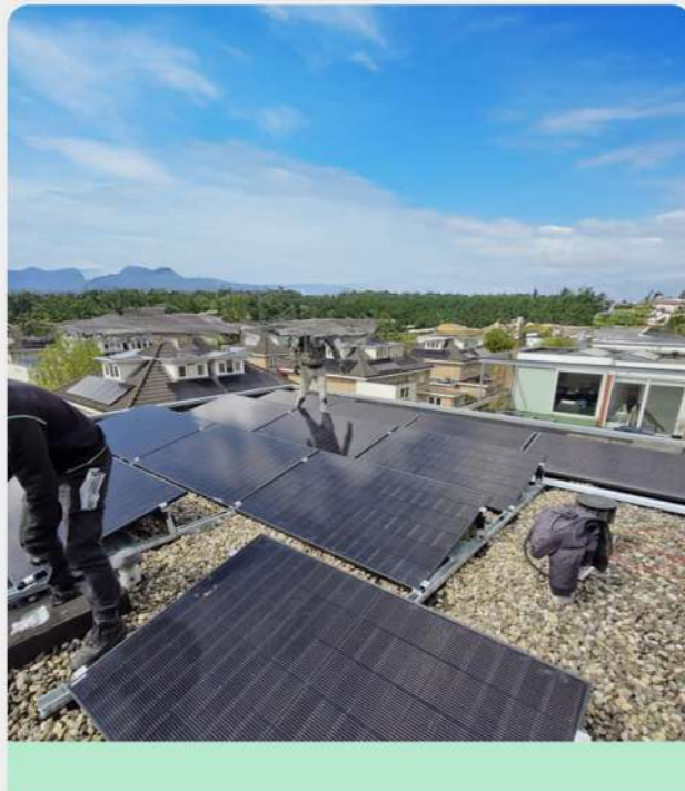
Onduleur Hybride, Batterie Haute Tension Rotterdam, Netherlands Capacité 10kW
