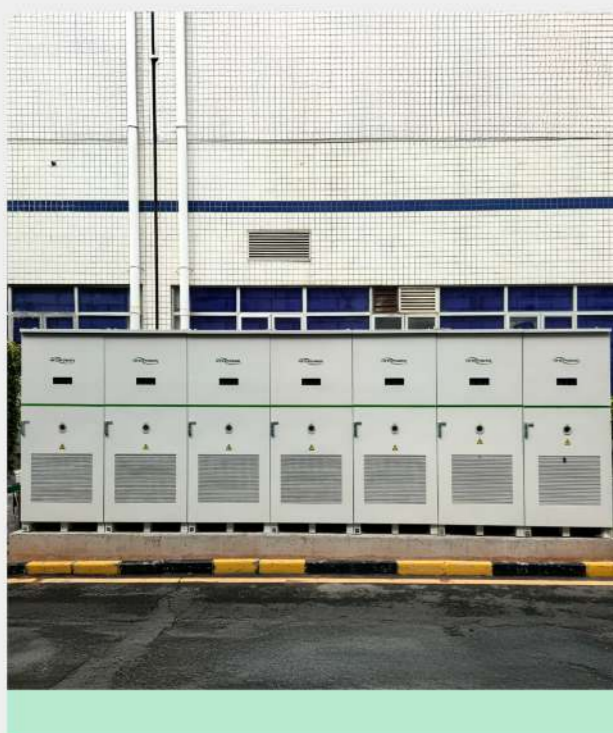
105kW/232kWh Système de stockage avec refroidissement liquide Guangdong, China Capacité 3.25MW/7.19MWh
