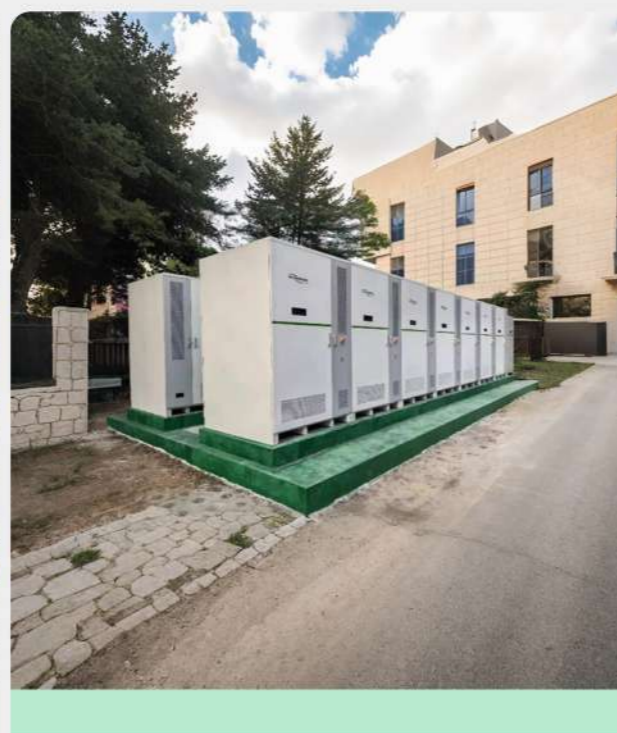
105kW/232kWh Système de stockage avec refroidissement liquide Guangdong, China Capacité 2.32MW/4.64MWh
