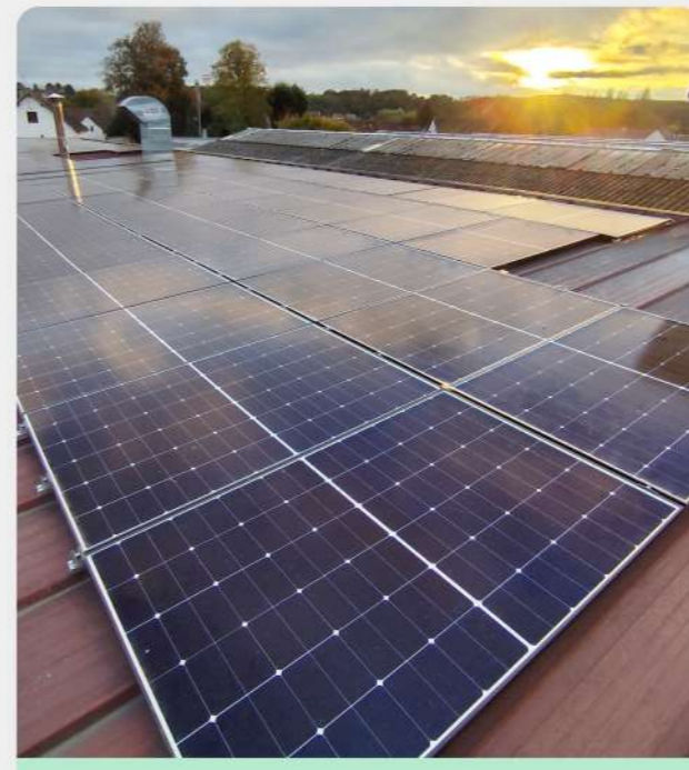
Onduleur Réseau Nogent-le-Roi, France Capacité 40kW
