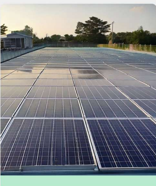
Inversor String de 50 kW/110 kW Zhejiang, China, Capacidade 3,67 MWp
