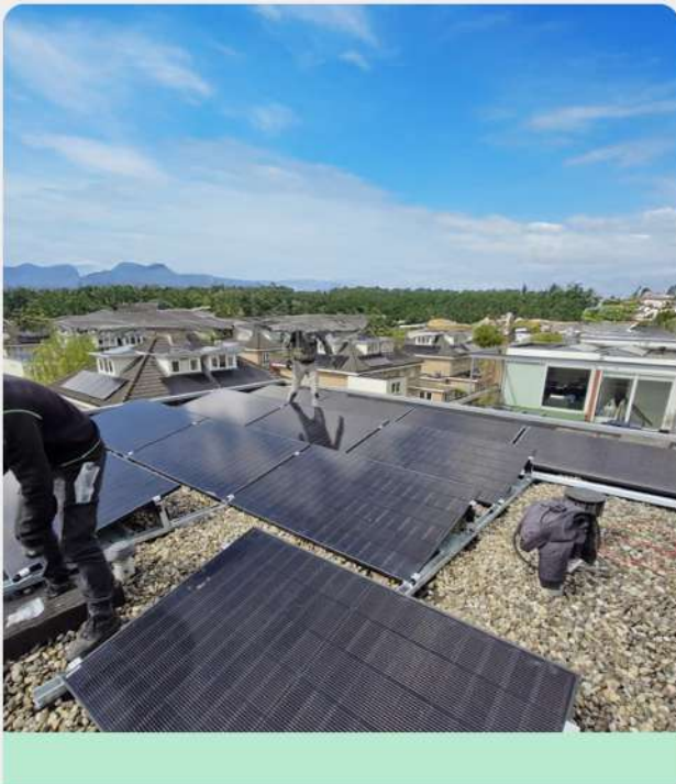
Inversor Híbrido, Bateria de Alta Tensão Rotterdam, Holanda - Capacidade: 10 kW
