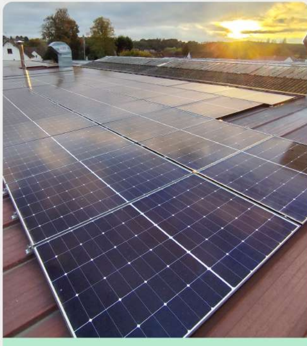
Inversor String Nogent-le-Roi, França - Capacidade: 40 kW
