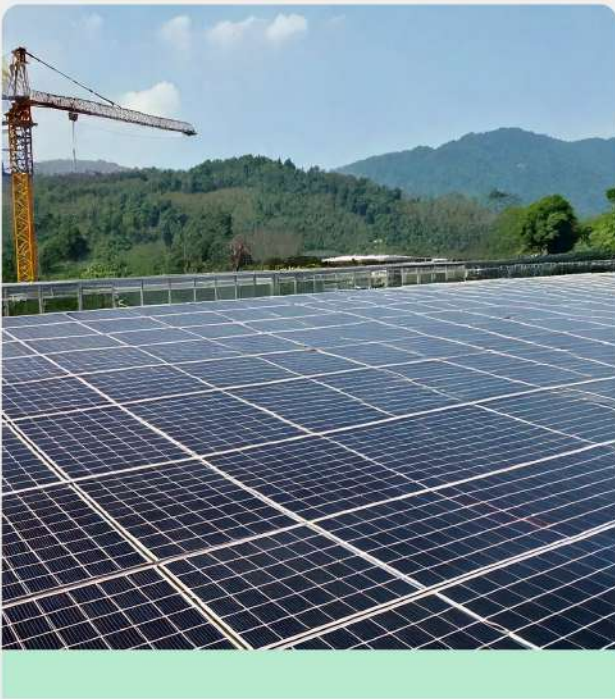
Inversor String de 50 kW/110 kW Zhejiang, China, Capacidade 4 MWp
