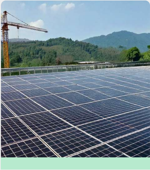
50kW/110kW 逆变器 浙江杭州 规模4.0MWp
