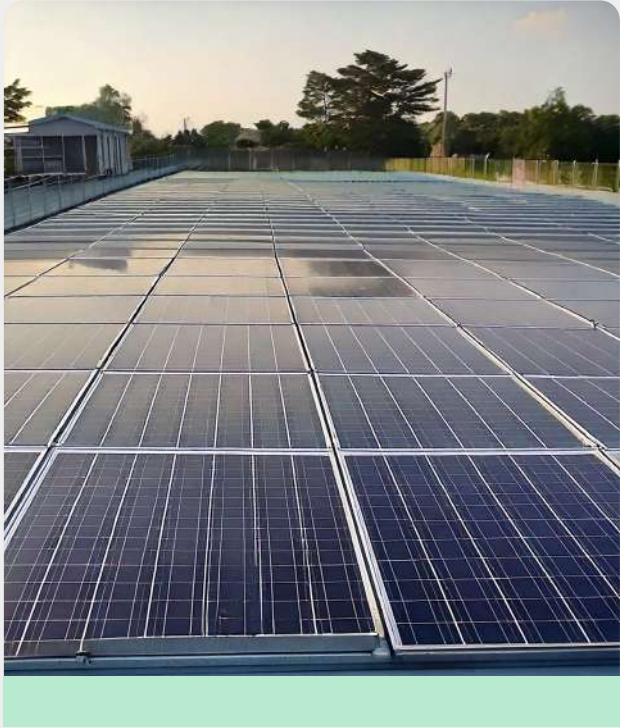
50kW/110kW 逆变器 浙江湖州 规模3.67MWp
